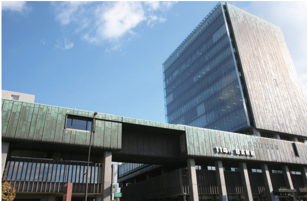
現在の本店（昭和41年竣工）
