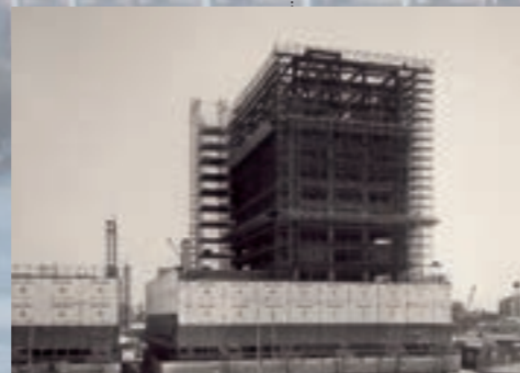
本店を現在地(高松市亀井町)に新築、移転
