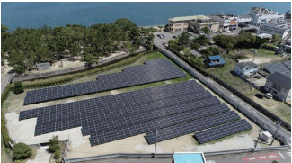
当行が自己活用する太陽光発電設備 (香川県さぬき市津田)
