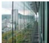
本店ビルは省エネルギーのために、壁面ガラスを断熱性に優れたガラススクリーンで二重に覆う「ダブルスキン工法」を用いています。
