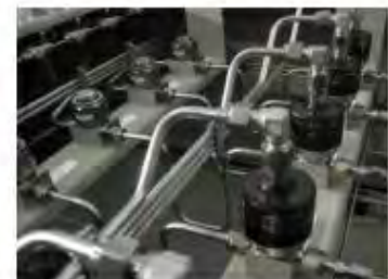
サンプリング盤(SUSチューブ6.8Φ)
