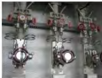
伝送器収納盤 プロセス配管 (SUSチューブ8Φ・キャピラリーチューブ3Φ)
