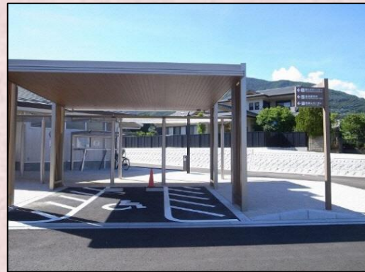
屋根のある車いす使用者用駐車場
