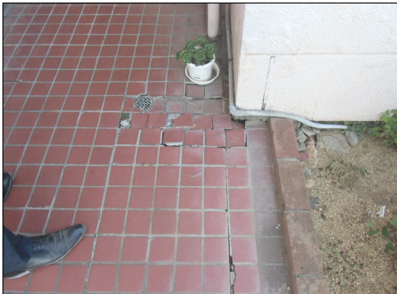
正面玄関 階段
