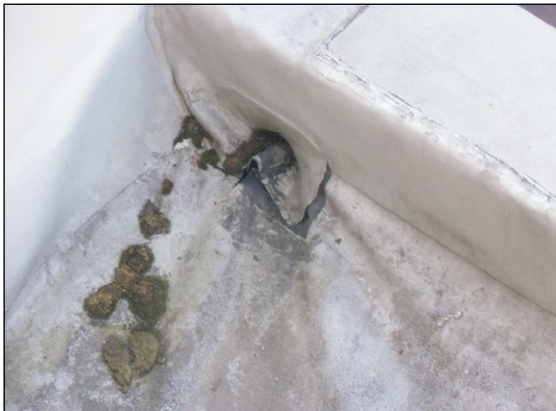
調理室 屋上防水
