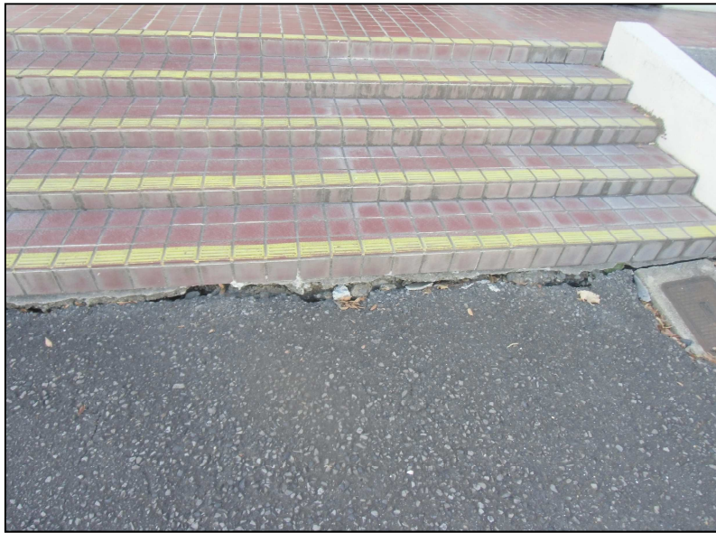
正面玄関 階段
