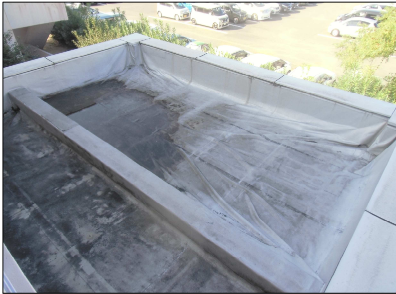
調理室 屋上防水
