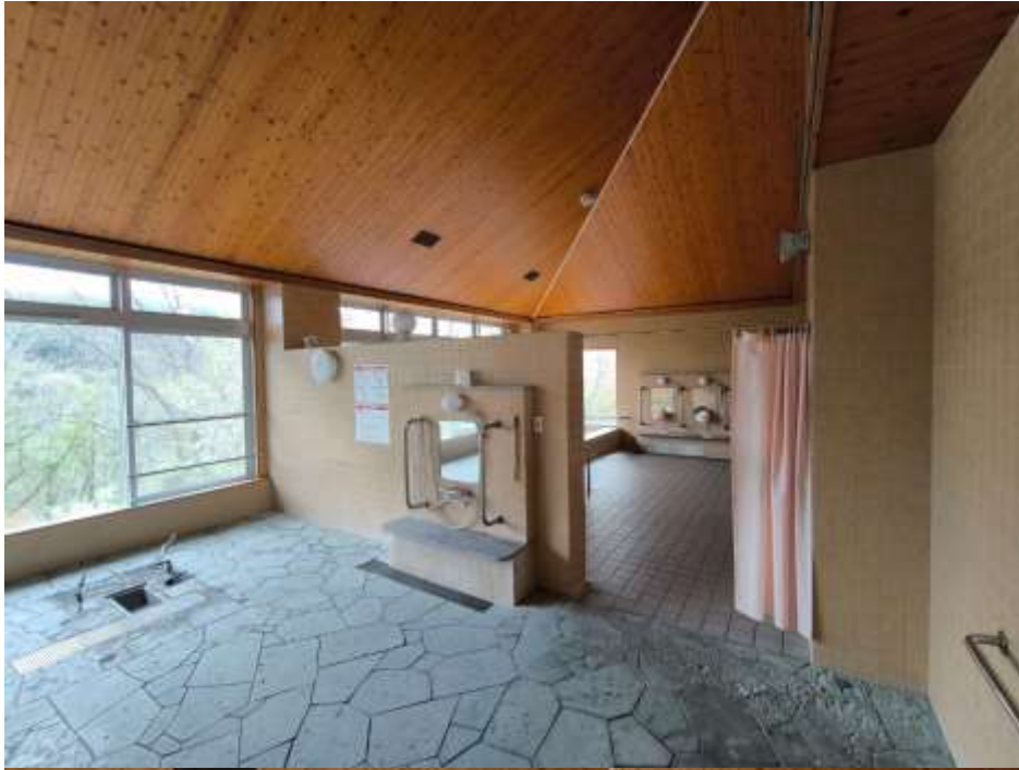
(12) 本館 2 階浴室 (浴槽側)
